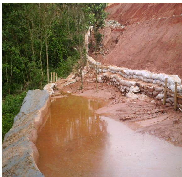
Figura III – nascente destruída pelo RODOANEL
