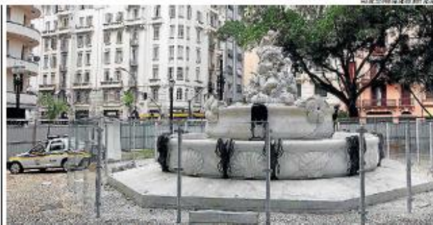
Renovação. Fonte estava pichada e sem algumas partes; restauro demorou oito meses
