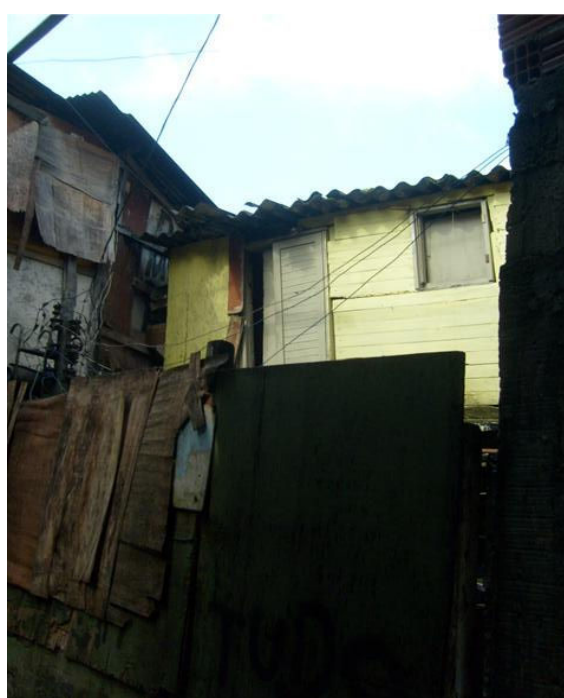
Figura 7 – Condições de habitação (barraco) da Vila São Paulo, Distrito de Cidade Ademar, cidade de São Paulo, 2009.
