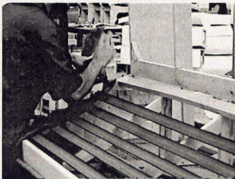
Figura 55 Trabalho de colocação de percinta
