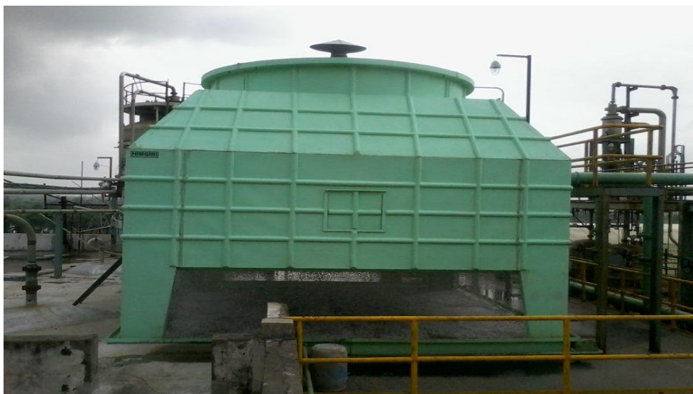
Figura 9 – Utilização de Água de reuso em torres de resfriamento.
