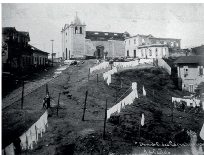
Imagem 79 – Demolição do Convento dos Capuchinhos, Morro do Castelo 11/3/1922
