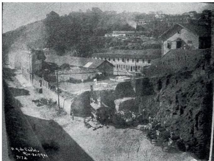
Imagem 76 – Demolição do Morro do Castelo, 30/7/1921
