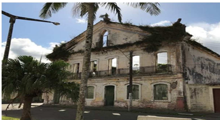
Figura 1: Situação atual da fachada do prédio. Foto: Wagner Magalhães – Julho de 2018
