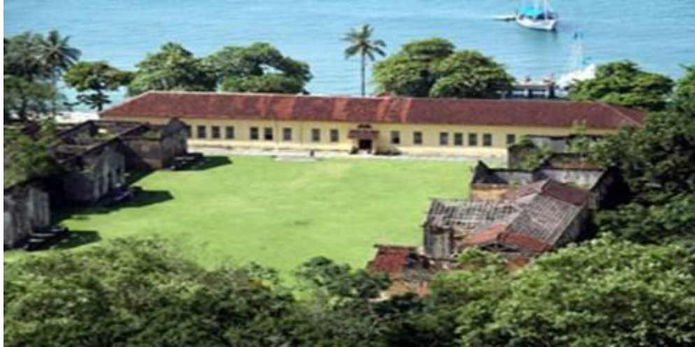
Figura 4: Ruínas Presídio Anchieta Fonte: (SÃO PAULO, 2013).
