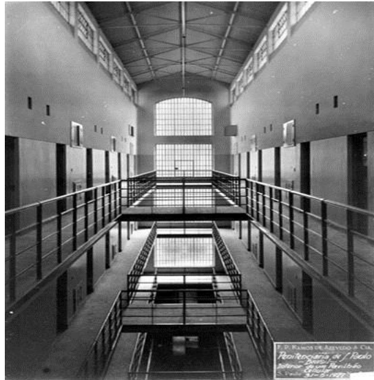
Figura 3: Vista Interna Penitenciária Do Estado Fonte: (SÃO PAULO, 2013).
