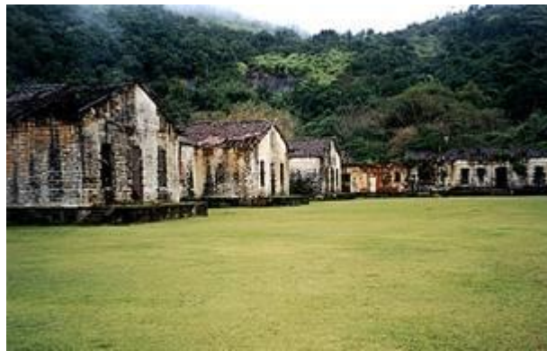
Figura 5: Ruínas Presídio Anchieta Fonte: (SÃO PAULO, 2013).
