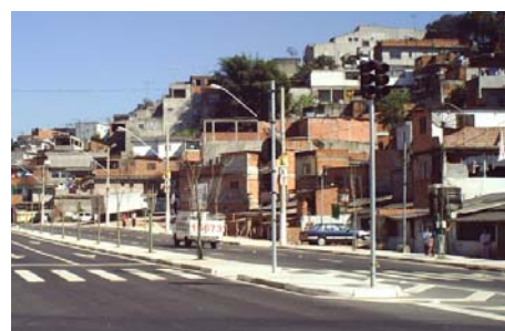
Obra de Urbanização Vera Cruz Canalização de Córrego (Acervo SEHAB - 2004)
