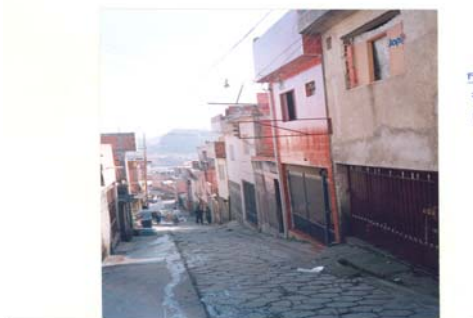
Abertura de Travessa no Núcleo Habitacional Sant’Ana (Acervo SEHAB -1992)
