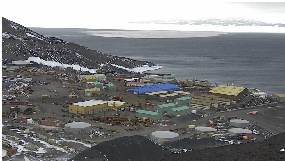
Figura 12 - Estação McMurdo, Ilha de Ross, Antártida. Essa é a principal instalação de pesquisa dos americanos no continente
