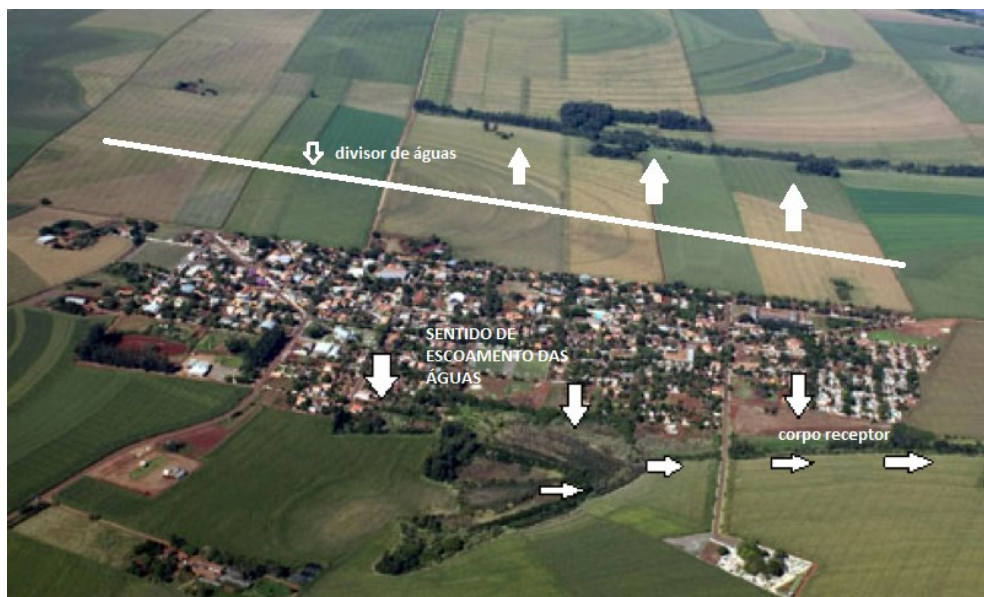
FIGURA 40 - SENTIDO DE DRENAGEM/ FUNDO DE VALE DA CIDADE DE IVATUBA
