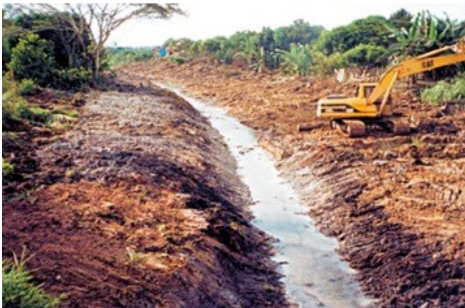
FIGURA 16 - CANAL NATURAL DA MACRODRENAGEM
