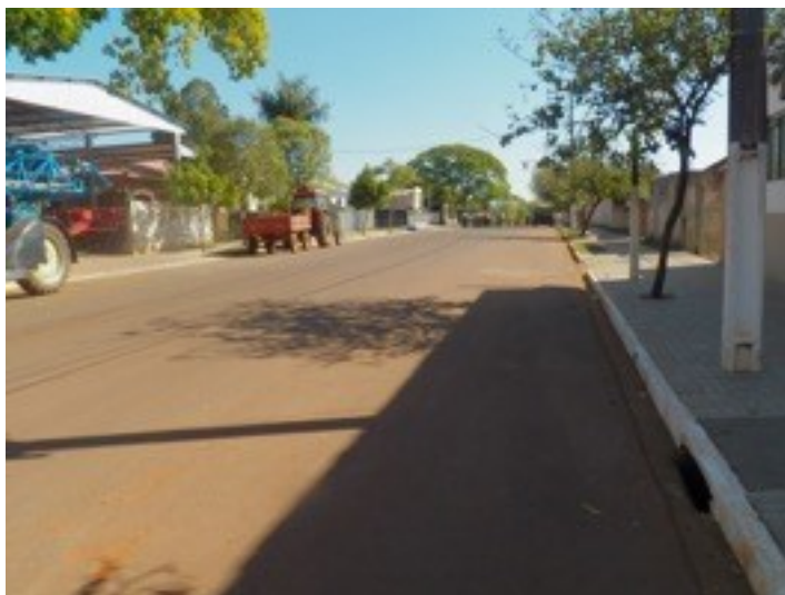
FIGURA 38 - VIAS PÚBLICAS PAVIMENTADAS, APRESENTANDO BOCAS-DE-LOBO, SARJETAS E GALERIAS SUBTERRÂNEAS
