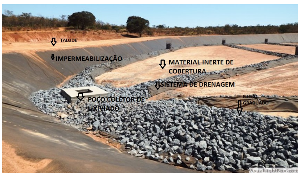
FIGURA 24 - FASE INICIAL DA CONSTRUÇÃO DE UM ATERRO SANITÁRIO
