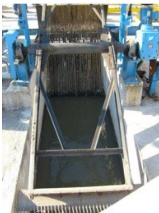
FIGURA 8 - GRADEAMENTO
