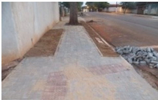
FIGURA 37 - IMPLEMENTAÇÃO DE CALÇADAS ECOLÓGICAS
