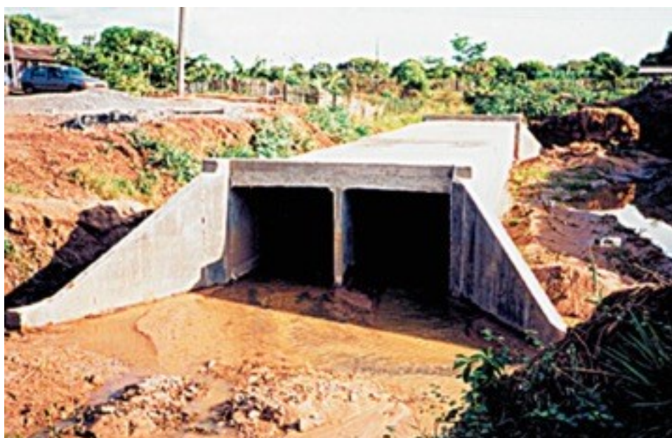
FIGURA 17 – GALERIA DE ÁGUAS PLUVIAIS
