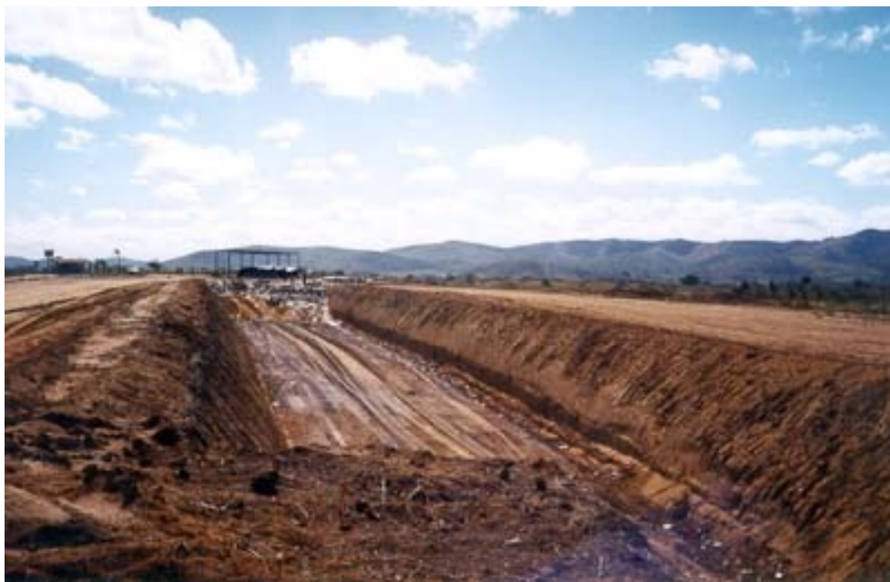
FIGURA 23 - CONSTRUÇÃO DE ATERRO CONTROLADO
