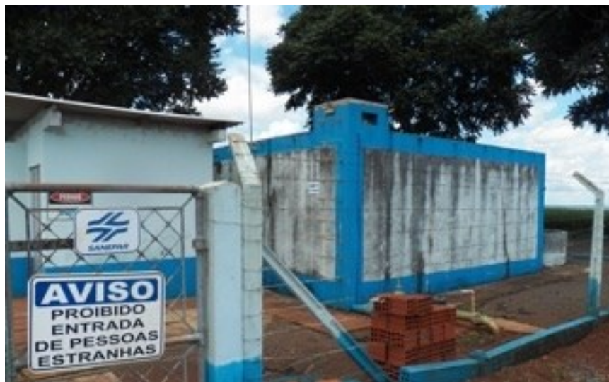
FIGURA 33 - SISTEMA DE RESERVAÇÃO E CLORAÇÃO DO SAA DA CIDADE DE IVATUBA
