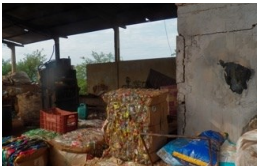
FIGURA 48 - BARRACÃO UTILIZADO PARA TRIAGEM E ARMAZENAMENTO DE MATERIAIS RECICLADOS
