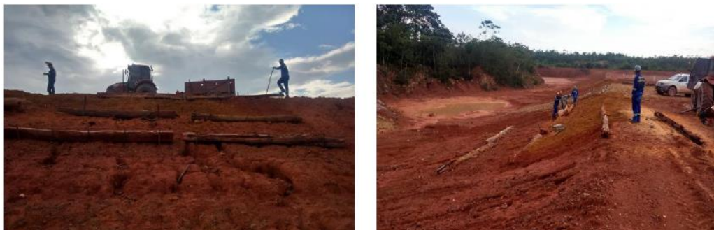
Figura 14 Evidência de aplicabilidade de lenha para implementação de manta geotêxtil no controle de erosões.
