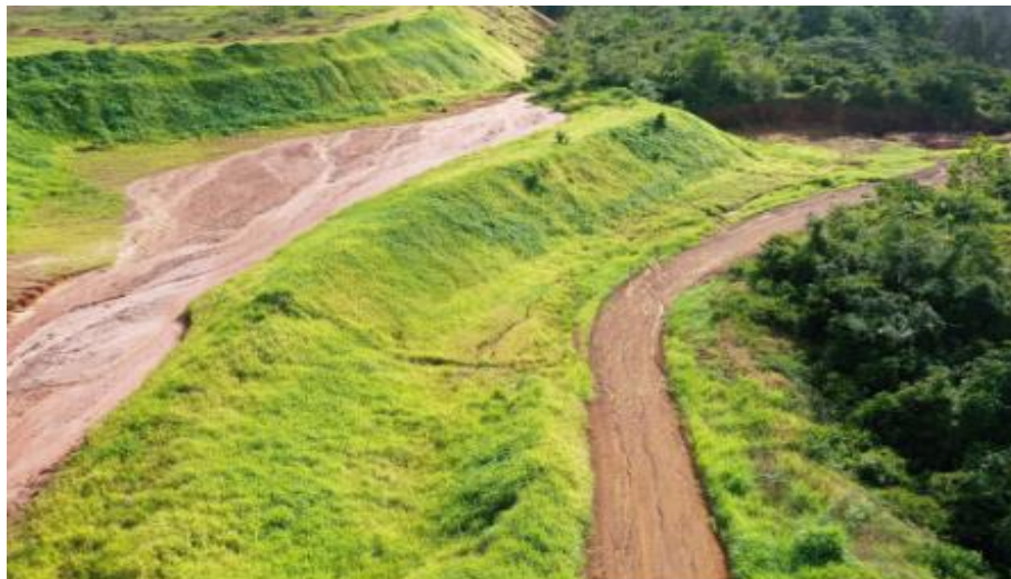
Figura 23 Avaliação fotográfica ( depois), Mina RCC Ipixuna do Pará – PA.
