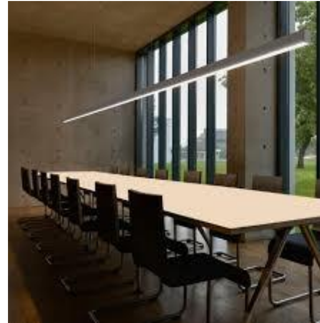
luminárias perfil suspenso + fita led
