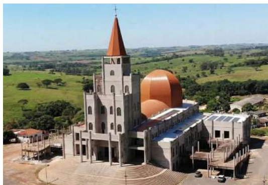
Novo Santuário, em construção desde 2010, prestes a concluir as obras. Divulgação
