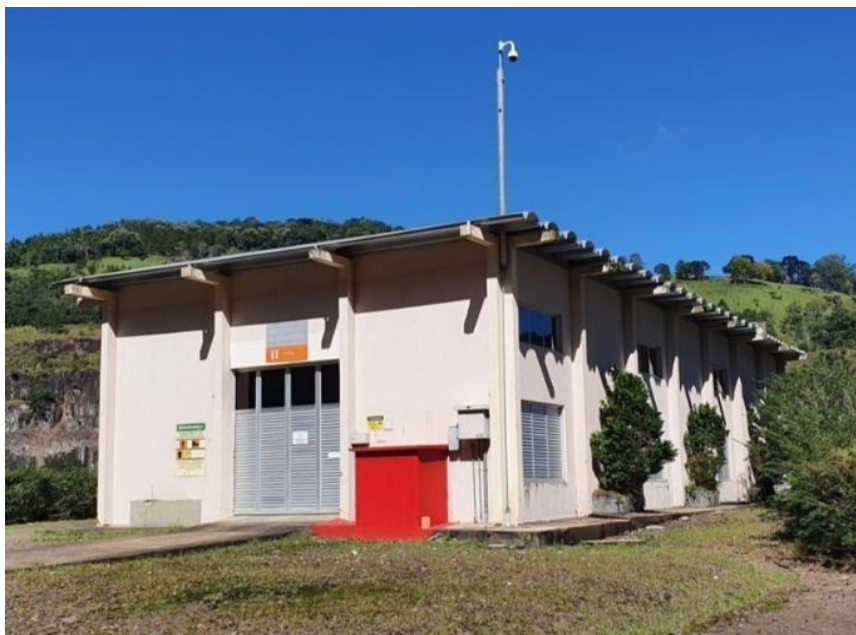
Figura 09 – Depósito de Armazenamento de Resíduos Perigosos de O&M
