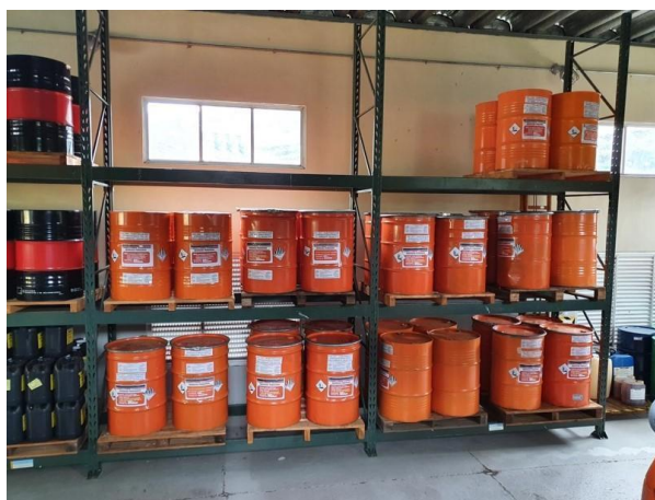
Figura 17 – Interior de Depósito de Resíduos Perigosos
