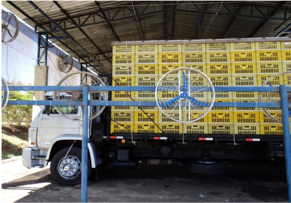
Figura 1: Caminhão na área de recepção com ventiladores e nebulizadores Fonte: Arquivo Pessoal
