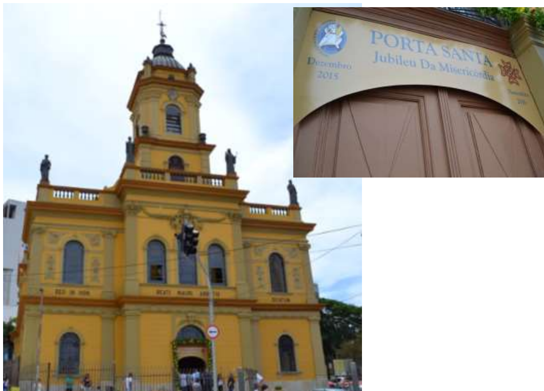
Figura 37 - Catedral de Santo Amaro – fachada restaurada e Porta Santa
