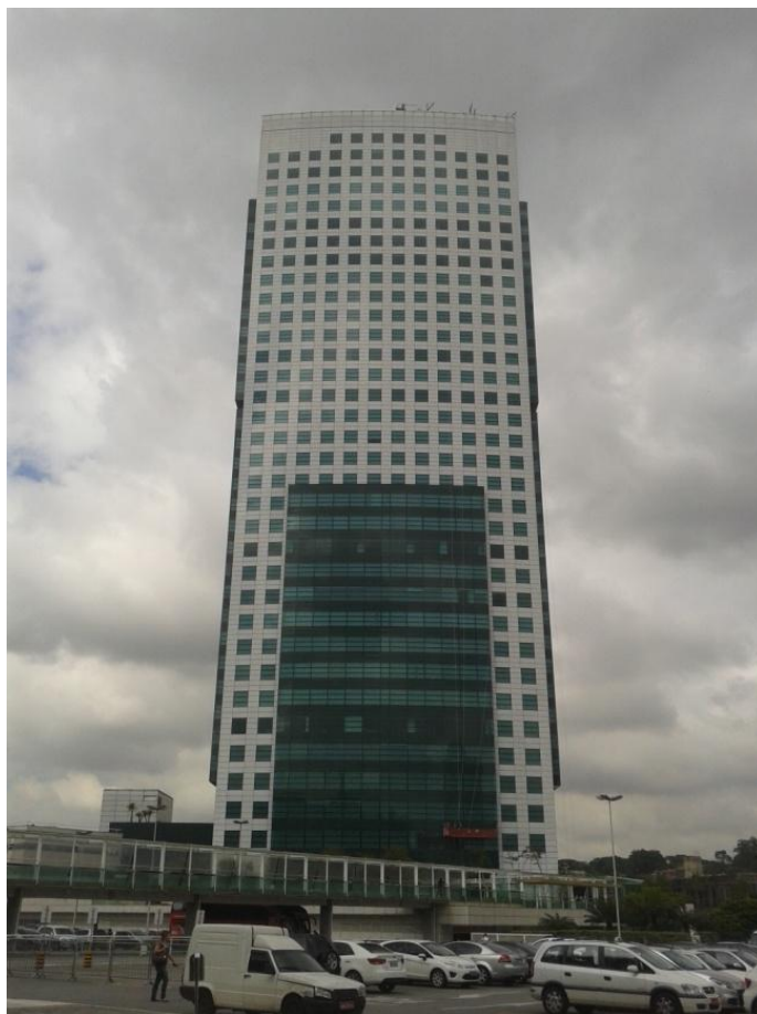
Figura 4 - Edifício Eldorado Business Tower em operação
