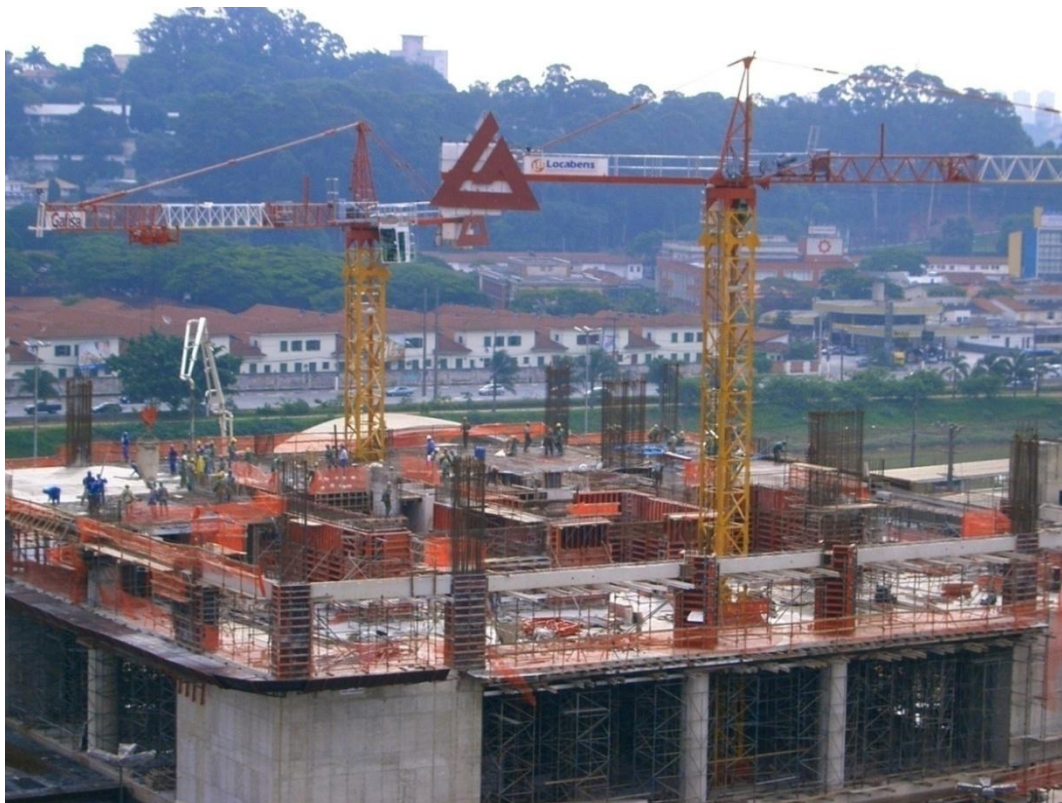
Figura 3 - Edifício Eldorado Business Tower em construção
